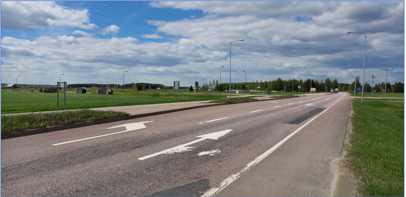
Kuva 8. Tiiliniityntie/Tiilitien -liittymän kanavointi Ylivieskantiellä. © Plandea.
