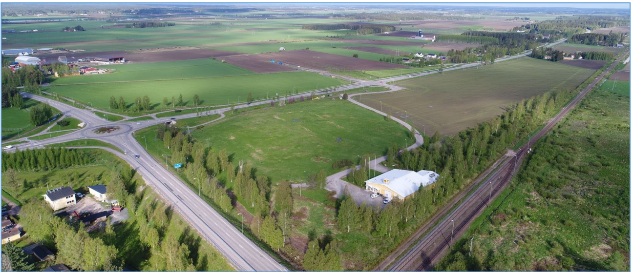
Kuva 2. Näkymä radan ylittävän sillan suunnalta suunnittelualueelle. © Plandea.
