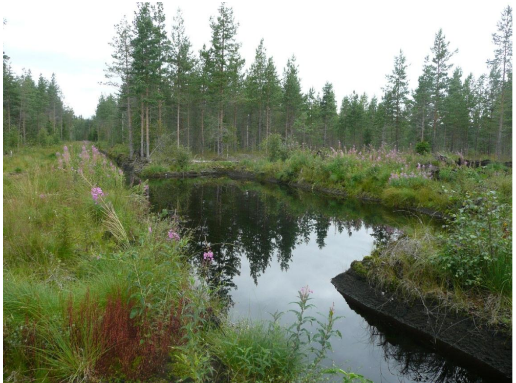
Kuva 7. Salmessa laskeutusallas, jonka läpi tulevat Teerinevan ojitetun suoalueen vedet. Laskeutusallas hidastaa veden virtausnopeutta ja pidättää kiintoainetta (kohde 49).
