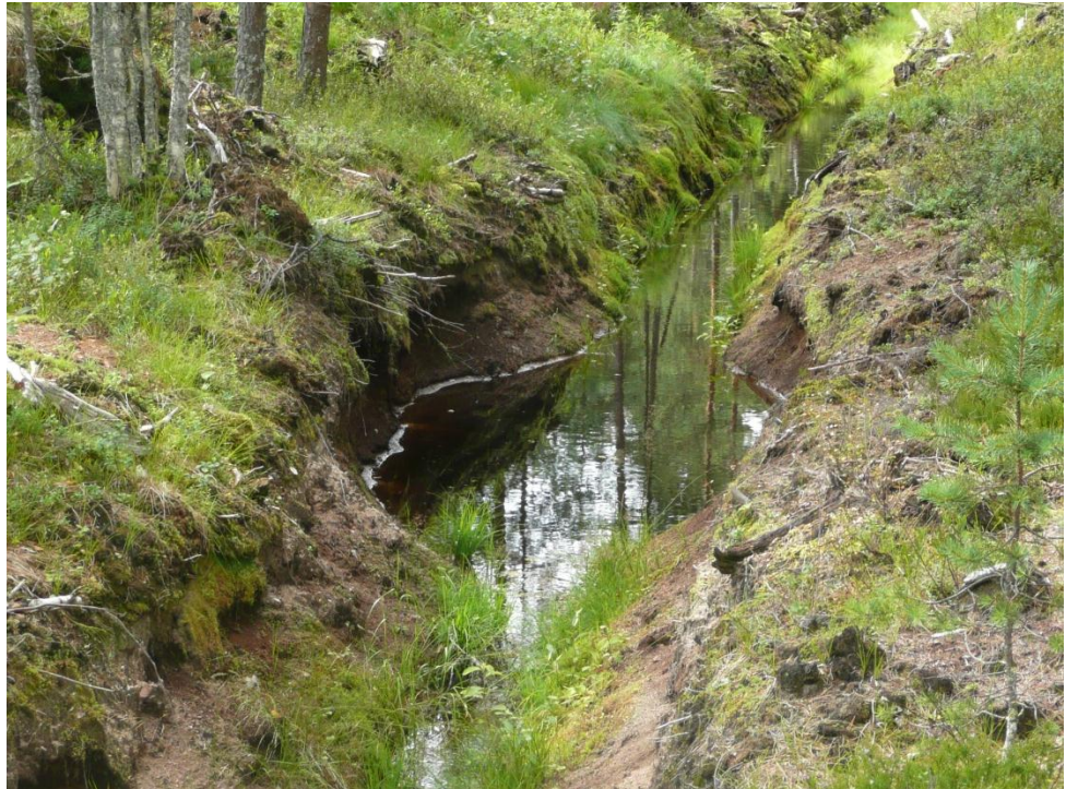
Kuva 5. Ristikankaalla suoran metsäojan päähän kaivettu lietekuoppa pidättää veden mukana kulkeutuvaa kiintoainetta (kohde 15).
