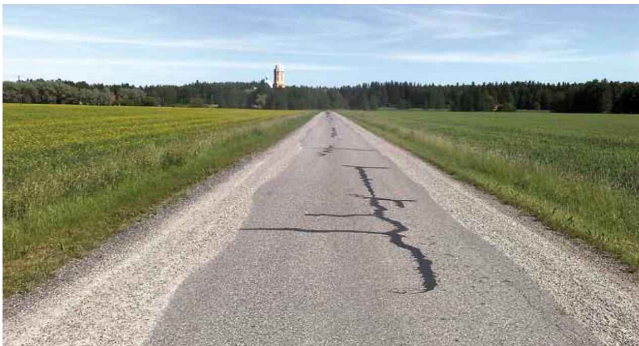
Päällysteen halkeamia on juotettu kumibitumilla.
