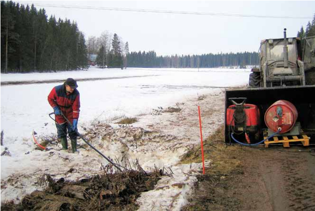
Rumpu voidaan sulattaa myös maataloudessa käytettävällä kuumavesipainepesurilla ja kuumavesisäiliöllä.
