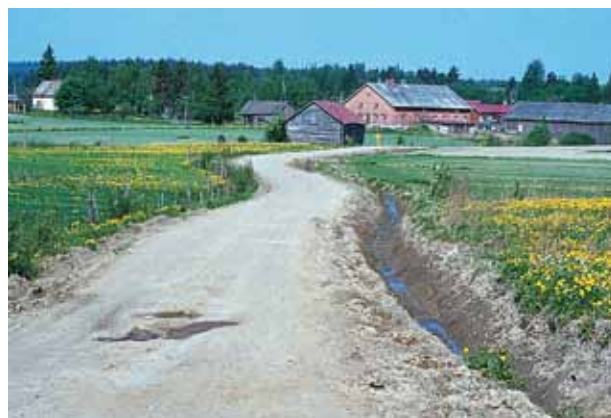
Kulutuserosmateriaalia on liian vähän.
