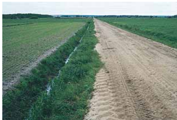
Kulutuserosmateriaali on liian tasarakeista.
